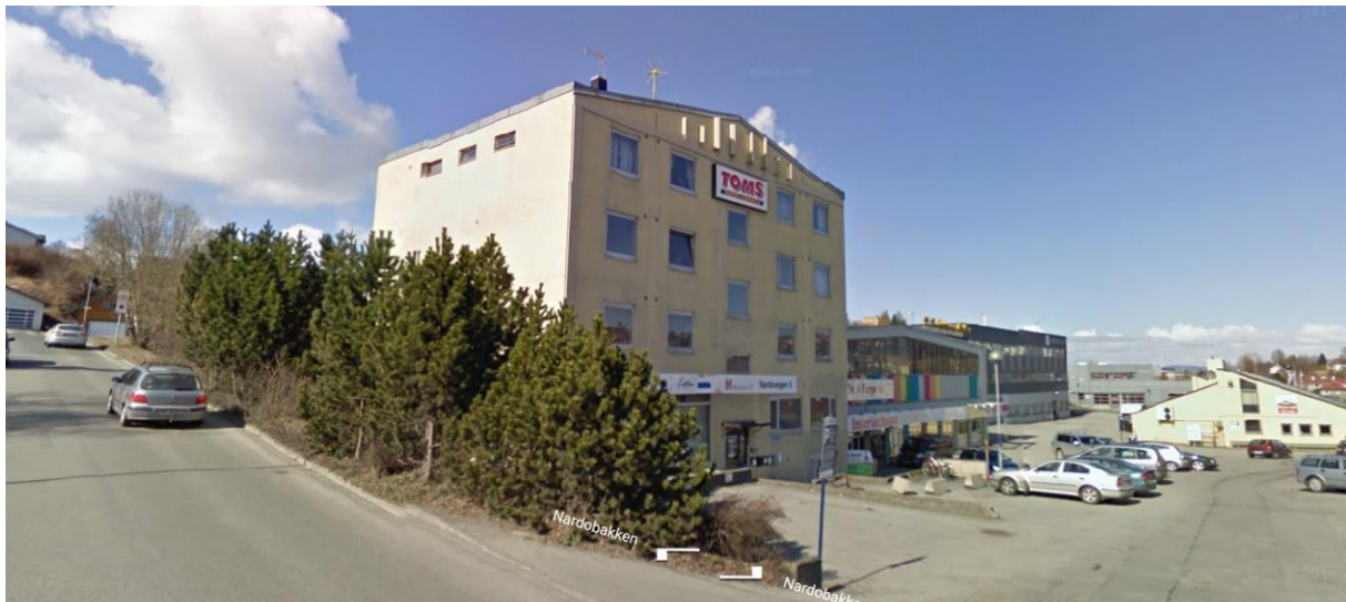
Figur 2 Dagens bygg, Nardovegen 6, sett fra sør-øst.
