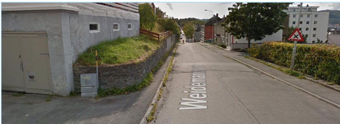
Figur 9 Langs Weidemanns vei 31, ikke fortau på sørsiden, forvarsling av farlig vegkryss
