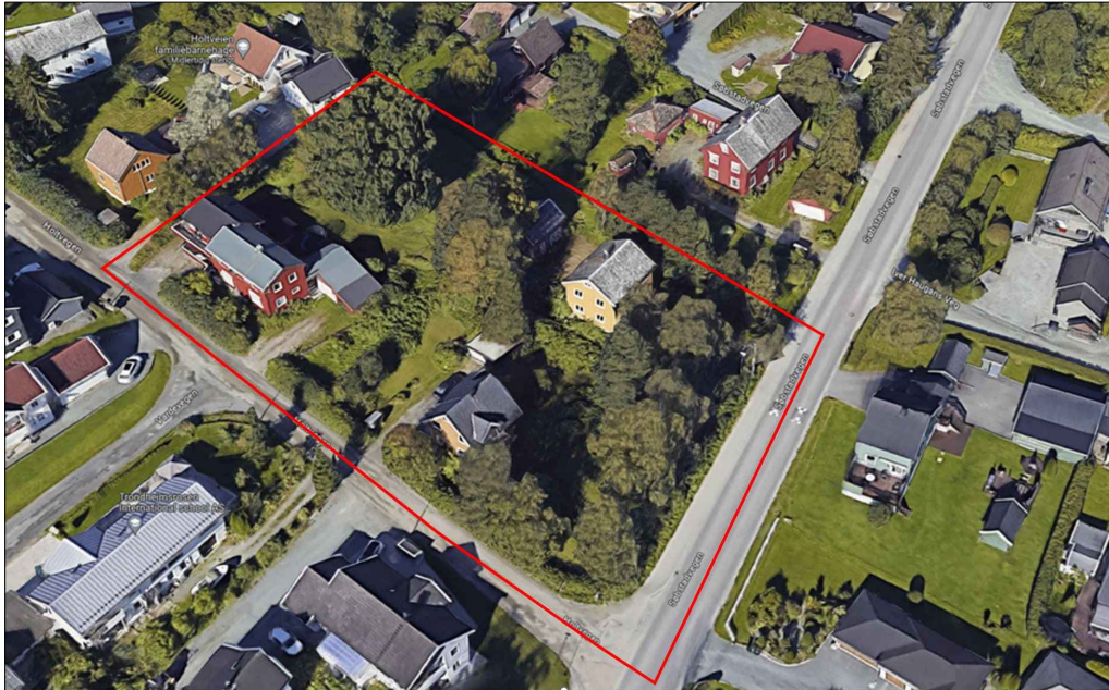
Figur 3. Oversiktsbilde fra sørøst. Kilde. Google maps.
