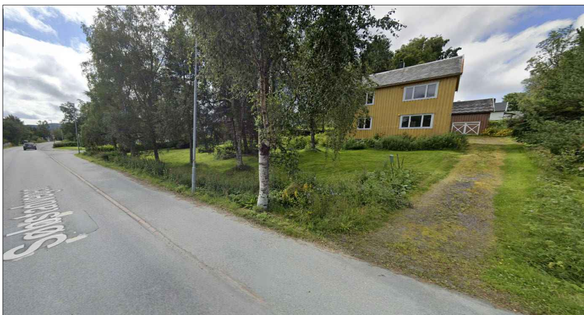
Eksisterende situasjon mot Søbstadvegen.
