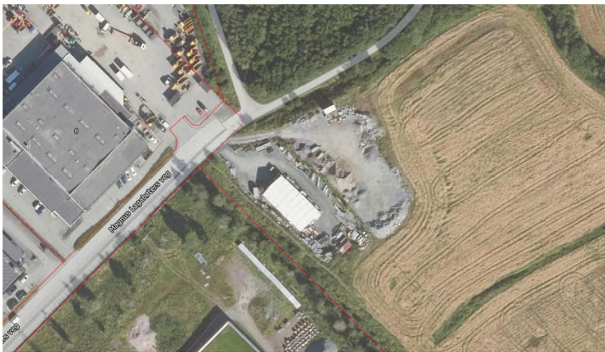
Figur 11 Flyfoto som viser området hvor fremtidig søppelsugsentral skal anlegges: dels dekket med anleggsunderlag i dagens situasjon.
