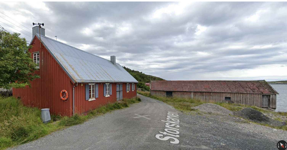
Figur 5. Det er to bygg innenfor planområdet som er registrert i Sefrak, som «lagerskur/sjøbod». Byggeår er ukjent, men de foreslås revet i planforslaget. Kilde. Google street view.
