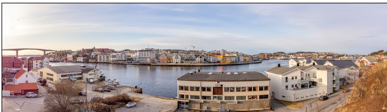
Figur 5. Eksisterende situasjon sett fra sør.
