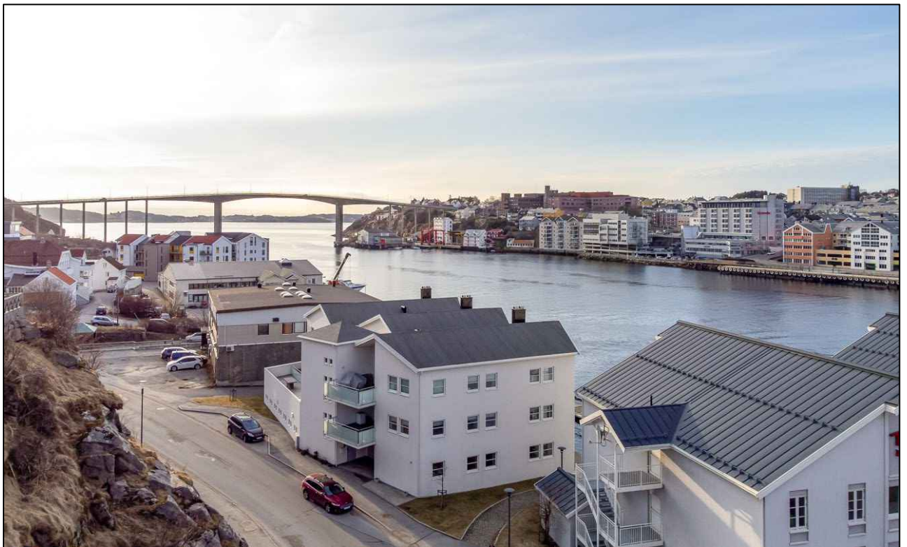
Figur 6. Planområdet sett fra øst. Eksisterende boligprosjekt (Fiskergata 14) midt i forkant av bildet.
